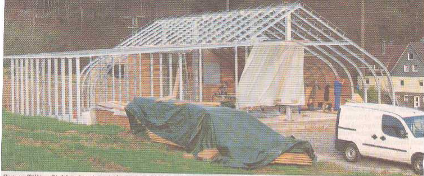
Das auffällige Stahlgerüst des „Außenhauses“ der van Harlessems steht. Nun wird das „Innenhaus“ als Wohnhaus hineingebaut.
